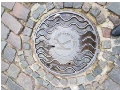
D178. attēls. Komunikācijas šahtas vāks. Autoru foto.
