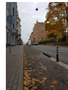
D217. attēls. Norobežojošie stabiņi un atduras elementi velojoslas atdalīšanai no brauktuves. Lāčplēša iela.
