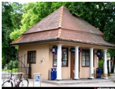
D298. attēls. Vērmānes dārza kioski
