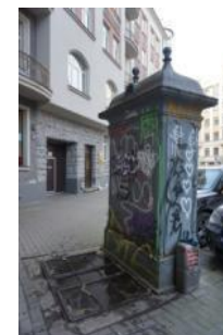
D177. attēls. Sadalnes skapis. Ģertrūdes iela. Autoru foto.
