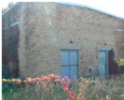
12.3.att. Kanalizācijas sūkņu stacija Ūdeļu ielā 4
