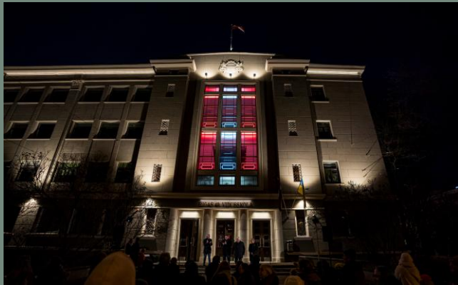
Rīgas 49. vidusskolas Krišjāņa Valdemāra ielā 65 atjaunotā fasāde
