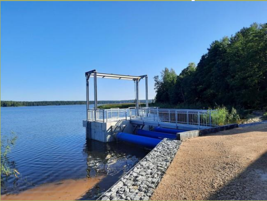
Infiltrācijas sūkņu stacijas ūdens ņemšanas vietas rekonstrukcija
