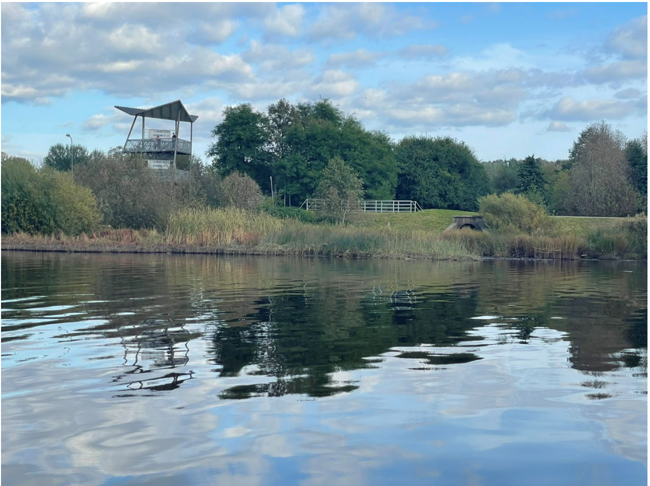
6.Att. Krasta iecirkņa centrālajā un ZR daļā ūdenslīnijas tuvumā ir izveidojies samērā blīvs veģetācijas apaugums, kas liecina par ļoti zemu erozijas risku normāla ūdenslīmeņa apstākļos. (skats no Daugavas 2025. gada 3. oktobrī)
