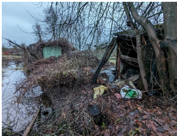
54. attēls. Ūdensmala ar sabrukušām būvēm un atkritumiem Lucavsālas austrumu pusē.
