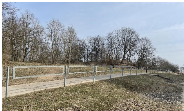
33. attēls. Esošais skats no A. Dombrovska ielas uz "Zaļās skolas" pakalnu (foto A. Katlapa)
