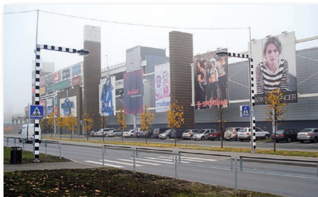
Izbūvēts papildu apgaismojums gājēju pārejai Ieriķu ielā.
