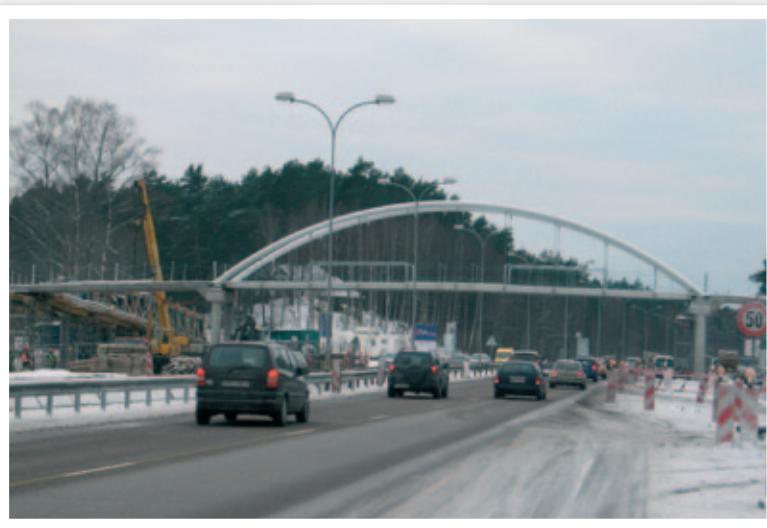
GĀJĒJU PĀRVADA PĀR KĀRĻA ULMAŅA GATVI PIE BEBERBEĶU IELAS BŪVNICĪBA. 2008. GADA DECEMBRIS
