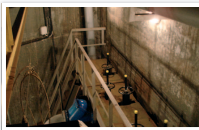
SŪKŅU STACIJA KRASTA IELĀ
