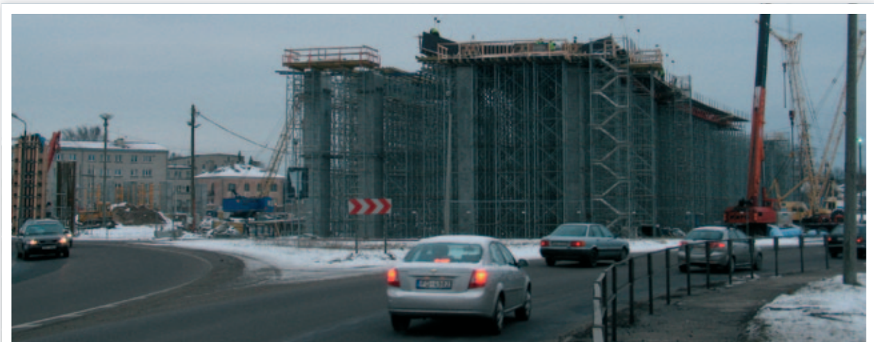
TRĪSLĪMEŅU ŠĶĒRSOJUMA BŪVNICĪBA SLĀVU ROTĀCIJAS APLĀ VIETĀ. 2008. GADA DECEMBRIS.
