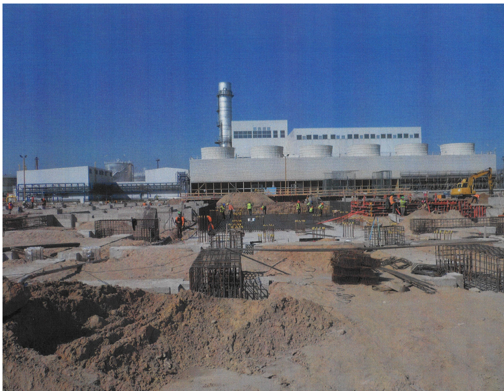
Attēls 2.6. Jaunā energobloka būvlaukumā Rīgas TEC-2 2010.gadā. Avots: AS „Latvenergo”
