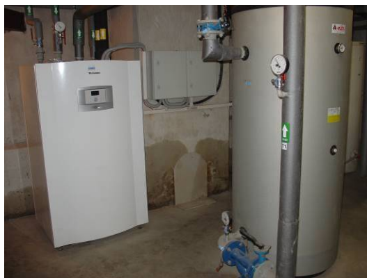
Attēls 2.22. Divpakāpju siltumsūknis un akumulācijas tvertne PII „Kastanītis”
