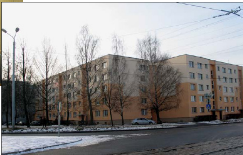
Attēls 2.21. Renovētās ēkas Kurzemes prospektā 14 un Bebru ielā 4.
