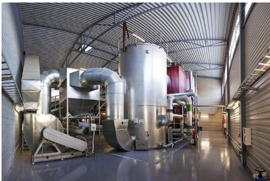
Attēls 3.6. Dūmgāzu kondensācijas ekonomaizera uzstādīšana biokurināmā katliem SC „Vecmīlgrāvis”. Avots: AS „Rīgas siltums”.
