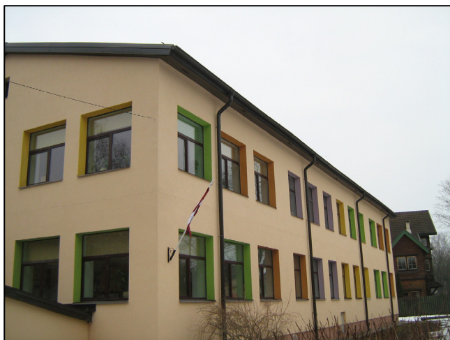
Attēls 4.5.-4.6. Renovētais komplekss Stokholmas ielā 3a.
