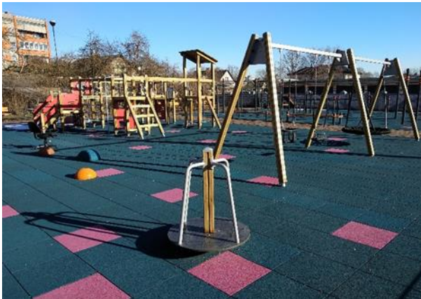
9.4.att. Bērnu rotaļu un jauniešu vingrošanas laukuma izbūve Kameņu ielā, Rīgā
