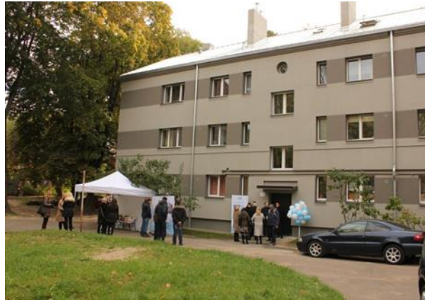
9.2.att. Atvērto durvju dienas noslēguma pasākums pie atjaunotās daudzdzīvokļu dzīvojamās mājas Ļermontova ielā 8, Rīgā
