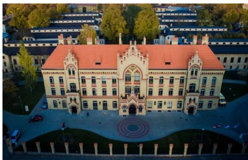
6.3.att. SIA "Rīgas 1.slimnīca" renovētā galvenā ēka
