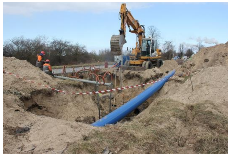
12.3.att. 2017.gadā veikta maģistrālā ūdensvada DN500mm atjaunošana Daugavgrīvas šosejā no sūkņu stacijas Voleri līdz Zilai ielai
