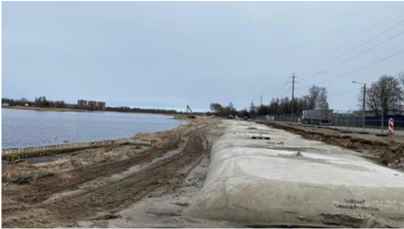
14.1.att. Pabeigta Buļļupes aizsargdambja kodola izveide
