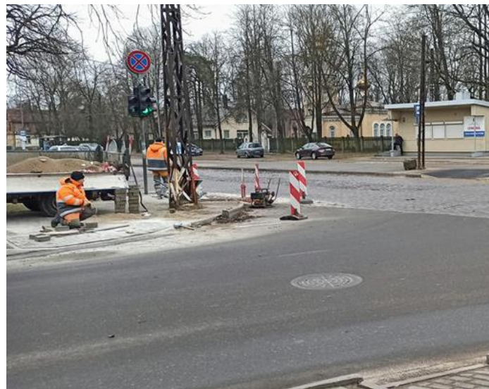
11.4.att. Apmalu likvidēšana pie gājēju pārejām
