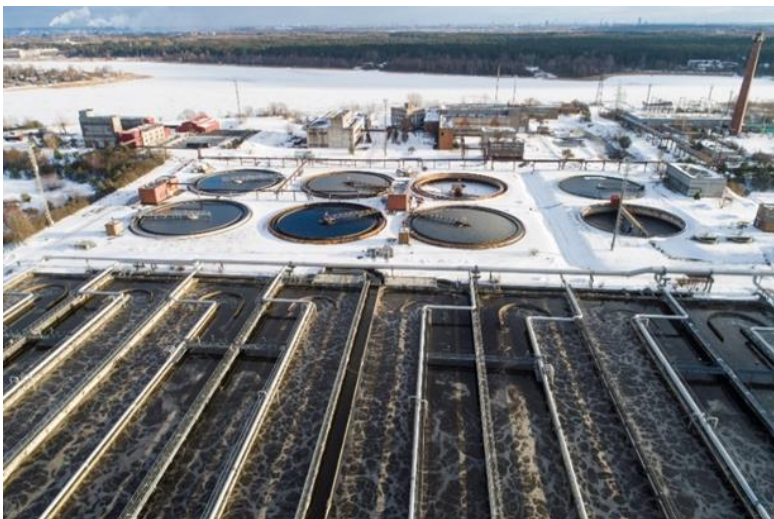
12.1.att. 2018.gadā pabeigta notekūdeņu bioloģiskās attīrīšanas stacijas "Daugavgrīva" 2. pirmējo nostādīnātāju pārbūve
