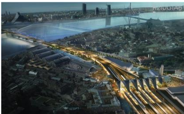
10.1.att. Rail Baltica
