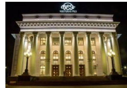
3.2.att. VEF Kultūras pils rekonstrukcija un restaurācija
