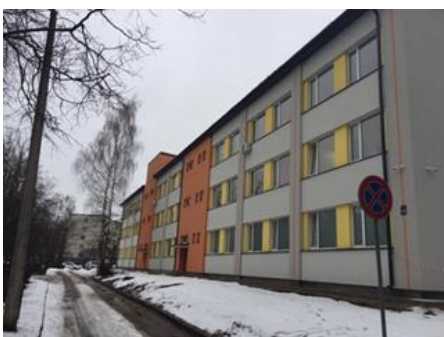
6.9.att. SIA "Rīgas veselības centrs" filiāles "Kengarags" ēka pēc renovācijas
