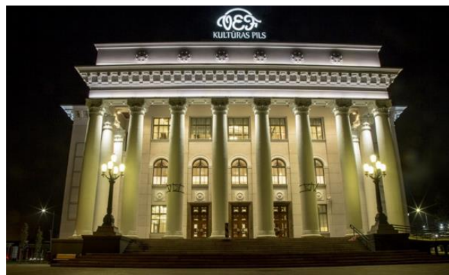
13.4.att. VEF kultūras pils rekonstrukcija un restaurācija
