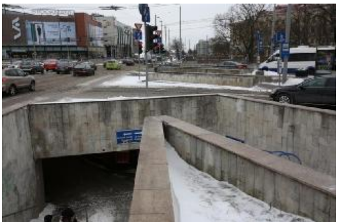
13. janvāra ielas un Raiņa bulvāra tunelis
