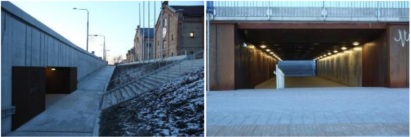
Gājēju tunelis Krasta ielā (pie Spīķeru ielas)
