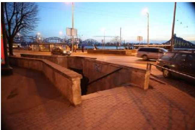
11. novembra krastmalas un Grēcinieku ielas tunelis
