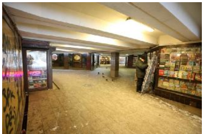
13. janvāra ielas un Raiņa bulvāra tunelis
