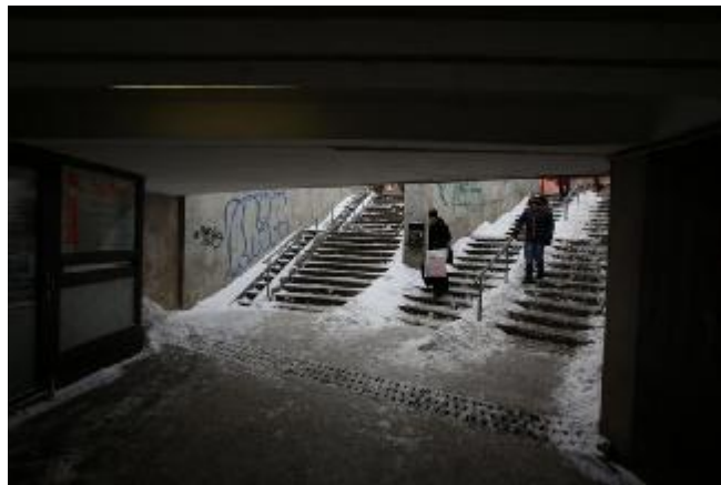
13. Janvāra iela un Raiņa bulvāra tunelis no t/c Origo puses
