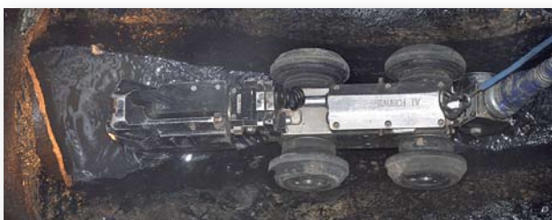
Lietus ūdens kanalizācijas sistēmas remonts Lielirbes ielā.
