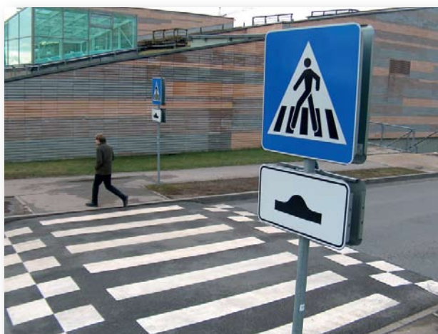
2009. gadā Āzenes ielā uzbūvētais ātrumvalnis.
