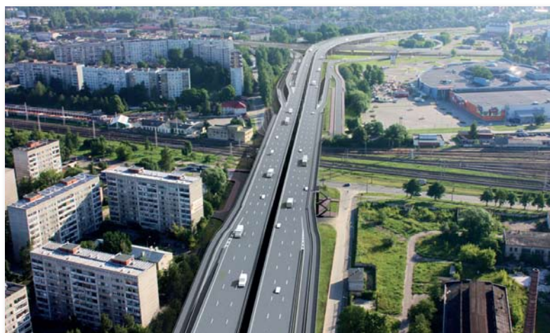
Slāvu ielas dzelzceļa pārvads 2009. un 2011. gadā.
