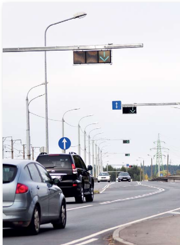
Maiņvirziena satiksmes josla uz tilta pār Mīlgrāvi.
