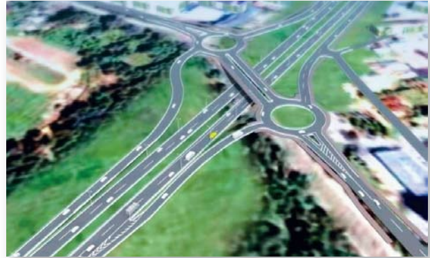
Jāņa Čakstes gatves un Bauskas ielas divu līmeņu šķērsojums – 2012. gadā.
