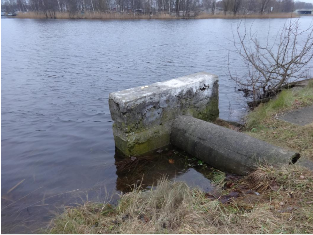
6.attēls LK izvads (dzelzsbetona cauruļvads)
