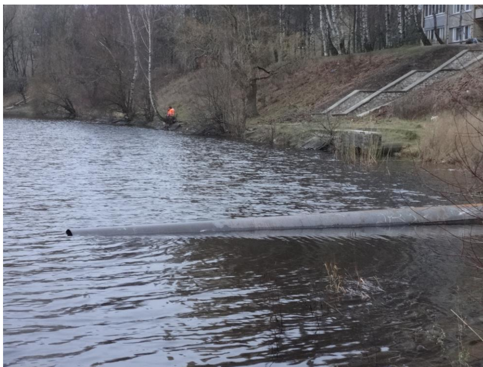
5.attēls LK izvads (metāla cauruļvads)
