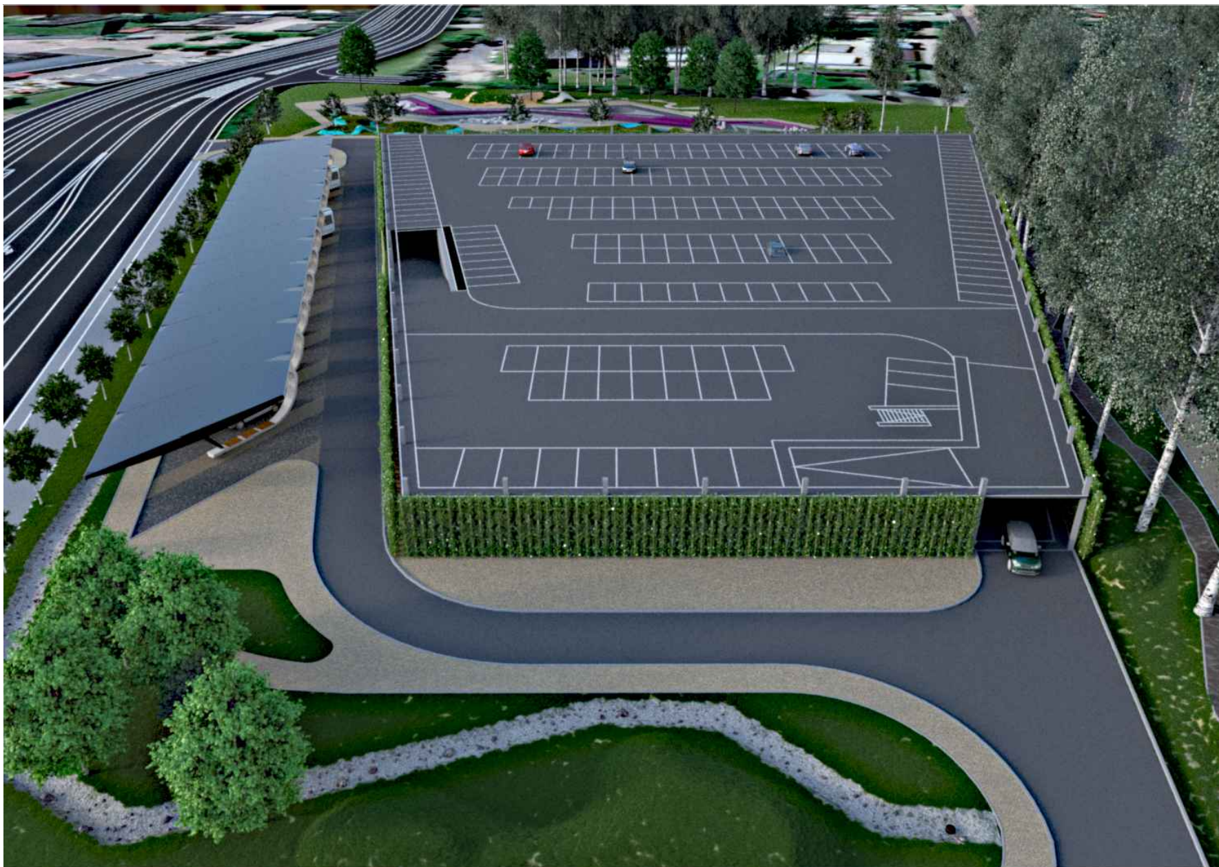
Skats uz divu līmeņu būvi bez pēdējā stāva pārseguma no Stāvparka ziemeļu daļas, kur priekšplānā redzama izbauktuve no autostāvlaukuma, vidusposmā autobusu pieturas zona, fonā ūdens uzkrāšanas baseins un Vilkaines iela.
