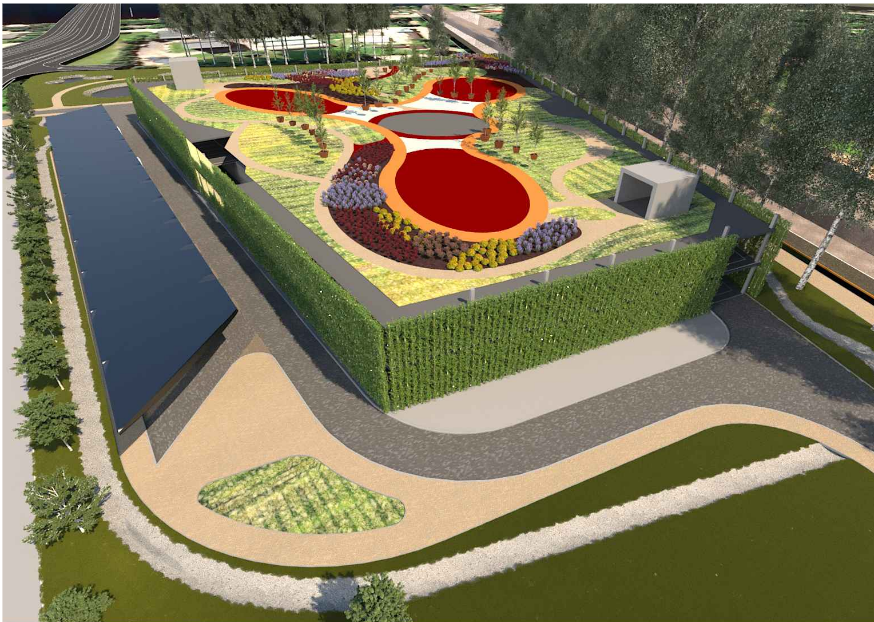
Skats uz divu līmeņu būvi ar pēdējā stāva parsegumu, kas veidots kā intensīvi izmantojams zaļais jumta dārzs. Stāvparka ziemeļu daļas priekšplānā redzama izbrauktuve no autostāvlaukuma, vidusposmā autobusu pieturas zona un fonā ūdens uzkrāšanas baseins ar infiltrācijas ieplakām.
