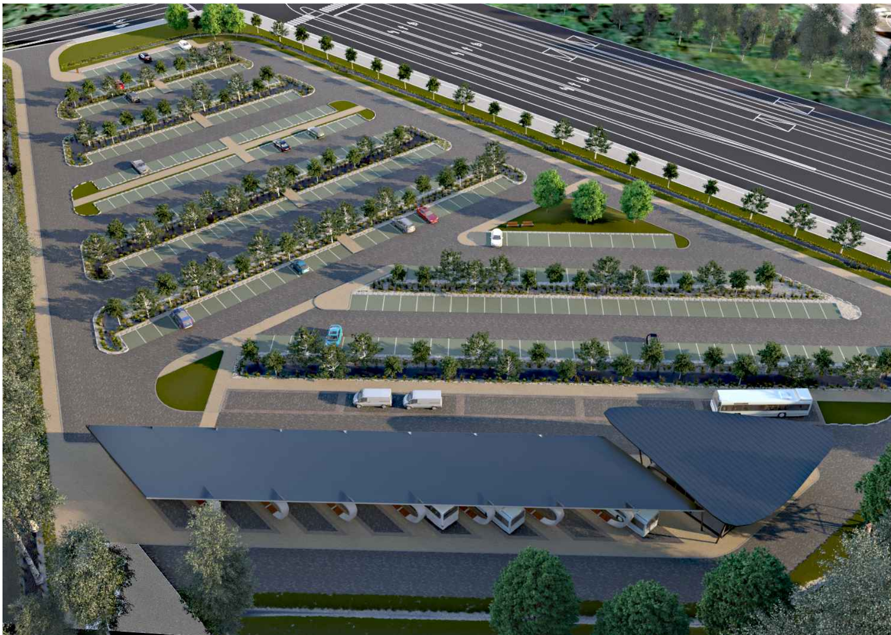
Skats uz viena līmeņa būves autostāvlaukumu ar 378 transportlīdzekļu stāvvietām, kur 292 stāvvietas paredzētas vieglo transportlīdzekļu novietošanai, 13 stāvvietas cilvēkiem ar kustību traucējumiem, 8 stāvvietas lielas ietilpības autobusiem, 5 īslaicīgas stāvvietas mazas ietilpības transportlīdzekļiem.
