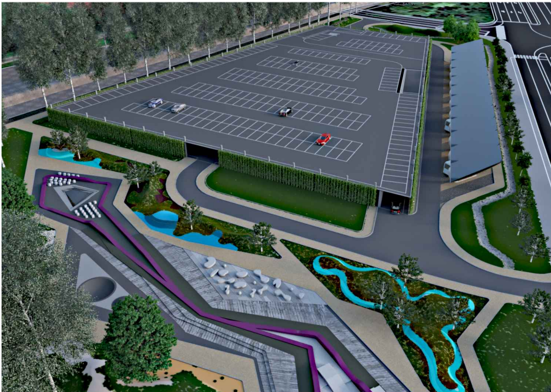
Skats uz divu līmeņu būvi bez pēdējā stāva pārseguma ar 512 transportlīdzekļu stāvvietām, kur 475 stāvvietas paredzētas vieglo transportlīdzekļu novietošanai, 25 stāvvietas cilvēkiem ar kustību traucējumiem, 8 stāvvietas lielas ietilpības autobusiem, 4 īslaicīgas stāvvietas mazas ietilpības transportlīdzekļiem.
